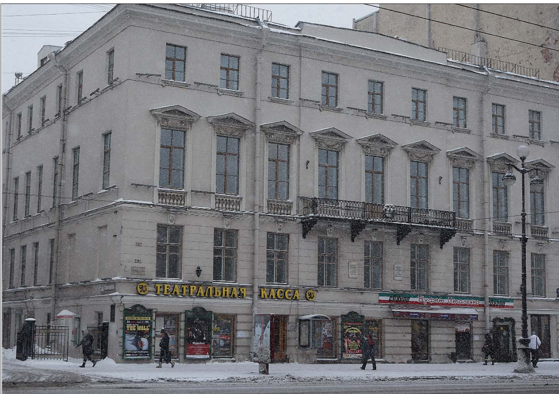
Дом № 42 по Невскому проспекту (современный вид)
