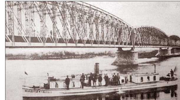
Патрульный катер стражи на охране железнодорожного моста через реку Сунгари
