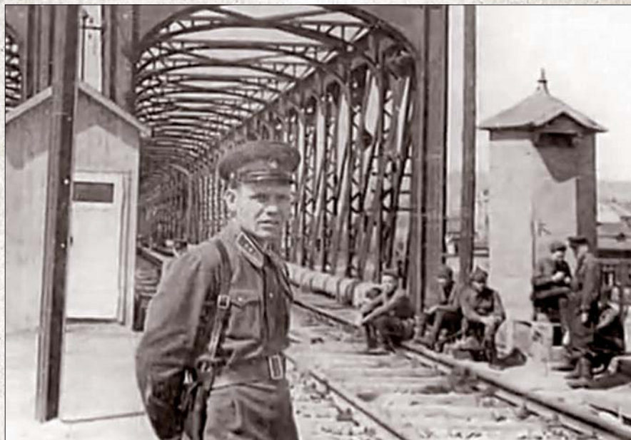
Гарнизон 66-го полка войск НКВД по охране железнодорожных сооружений на железнодорожном мосту между Перемышлем и Прёмзелем
