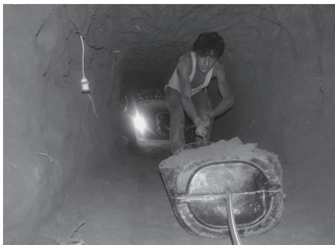
Юноша участвует в работах по созданию тоннеля
