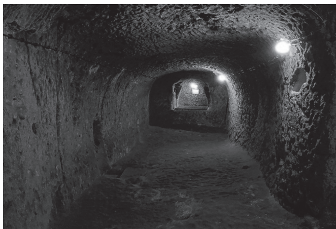
Захваченный тоннель в районе Дамаска
