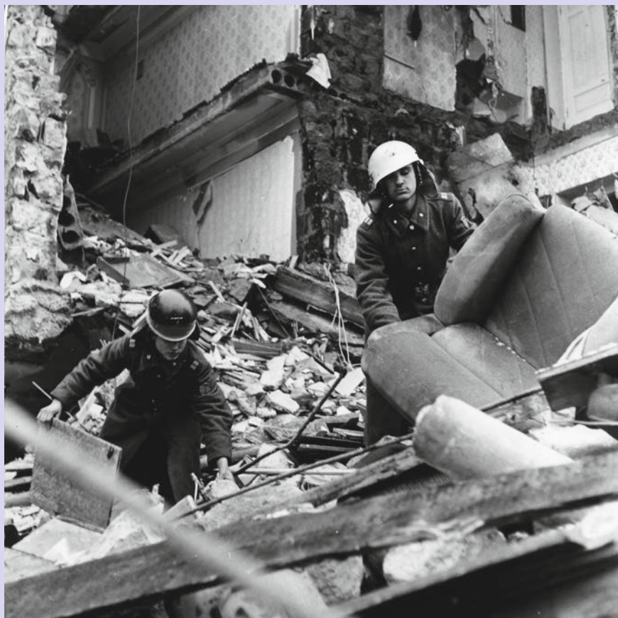
Ликвидация последствий землетрясения в г. Ленинакан
