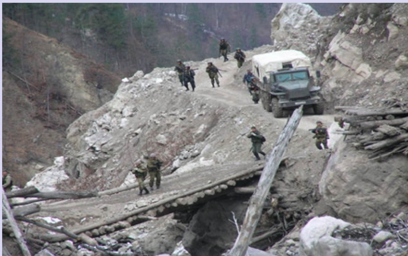
Временный мост в горах
