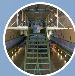
Смонтированная вторая палуба в грузовой кабине
