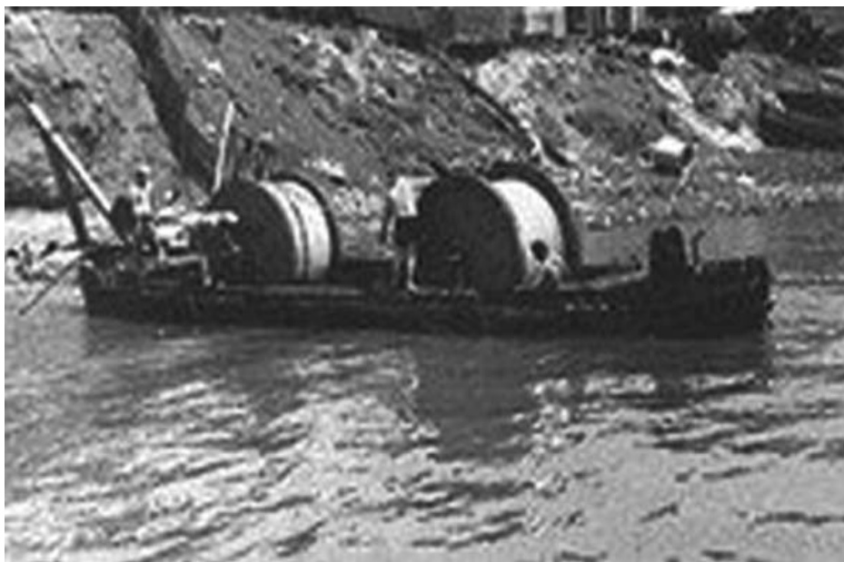
Прокладка линии связи по дну Волги
