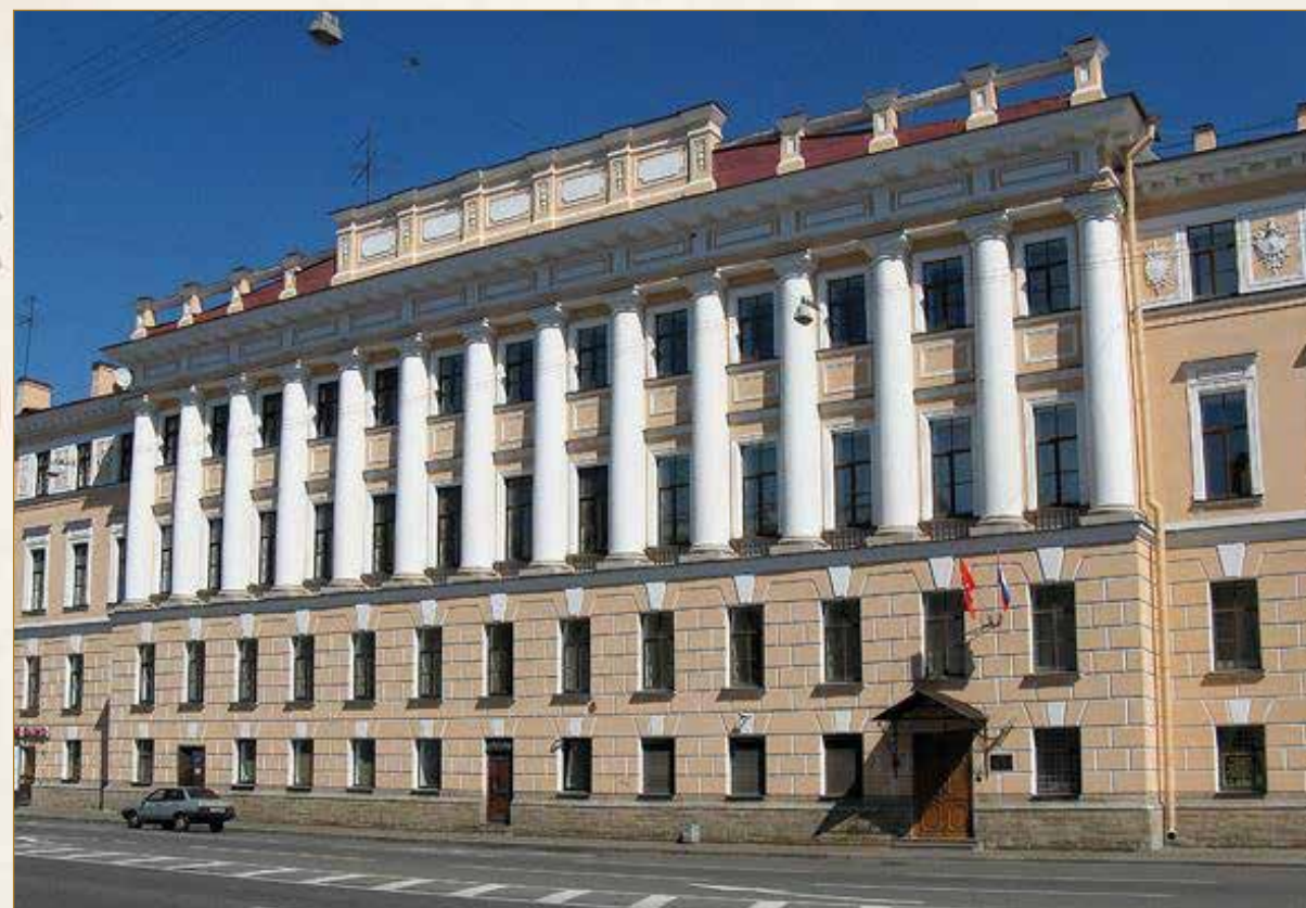
Комплекс казарм лейб-гвардии Измайловского полка. Офицерский корпус. Арх. Л. Руска
