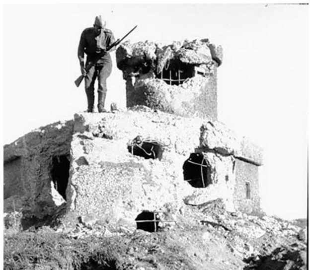
Разрушенный японский дом Хайларского укрепленного района. Забайкалье, 1945 год
