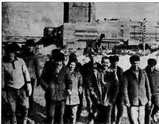
Строительство рудника «Комсомольский».
