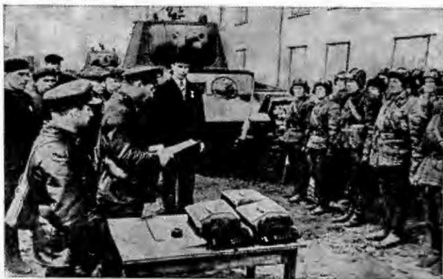
Рабочие металлического завода передают фронту отремонтированные танки. Ленинград. 1942 г.
