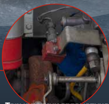
Термодатчик автоматической противопожарной системы
