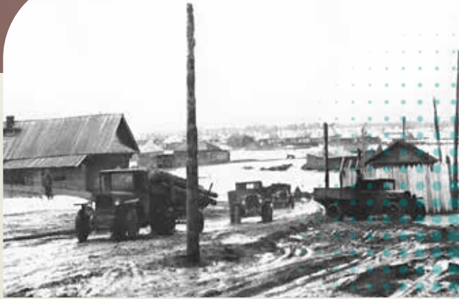
Строительство города Саров. конец 1940-х годов.
